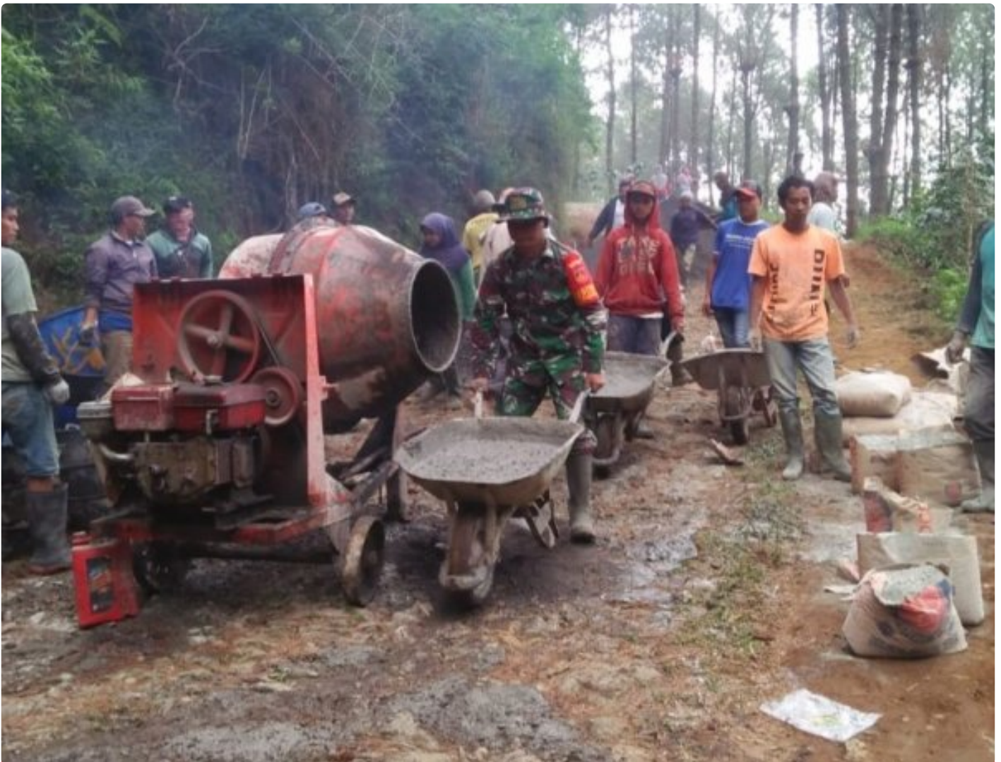
(Foto Dokumen) : Babinsa turut kerja bakti pengecoran jalan bersama warga binaan
